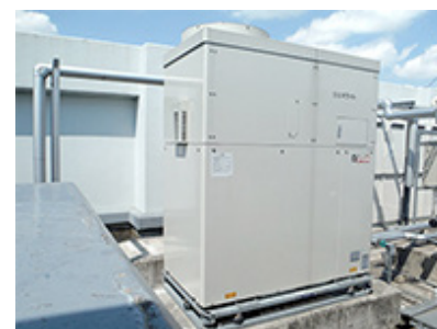
スバル総合研修センターに設置されたコージェネレーションシステム
